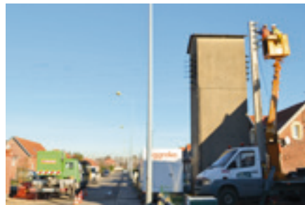
État des travaux le 30 novembre 2016
