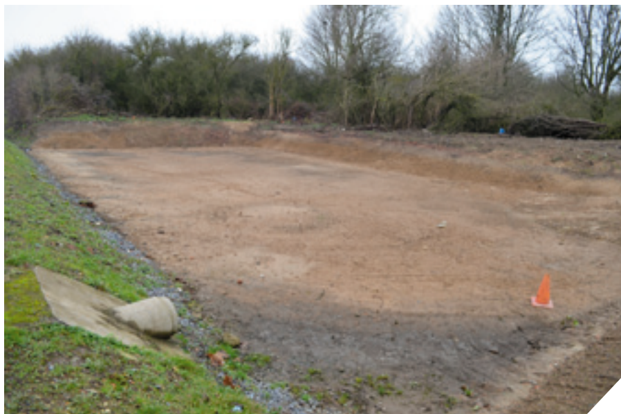
Bassin de rétention réalisé sur le secteur Monchy
