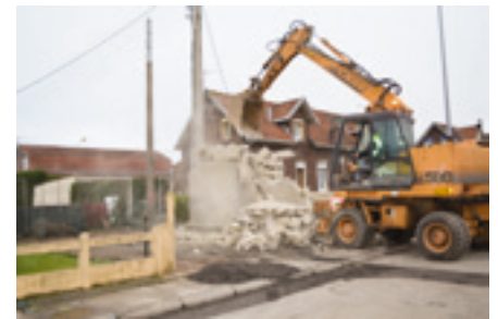
État des travaux le 12 décembre 2016
