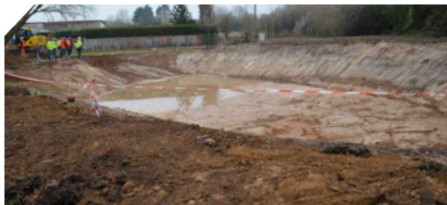
Réunion de chantier autour du bassin de rétention, rue des 4 Hallots, le 8 février.
