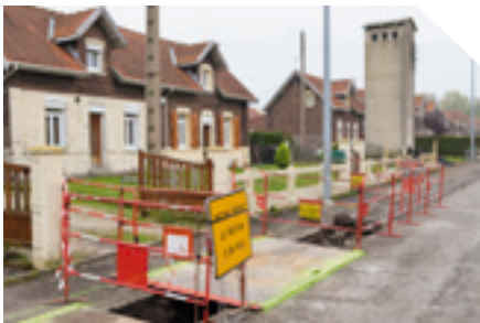
État des travaux le 24 octobre 2016
