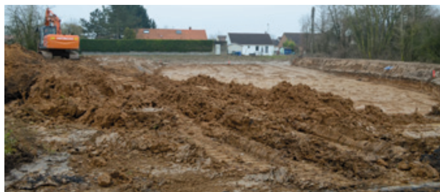
Bassin en cours de réalisation, rue des 4 Vents
