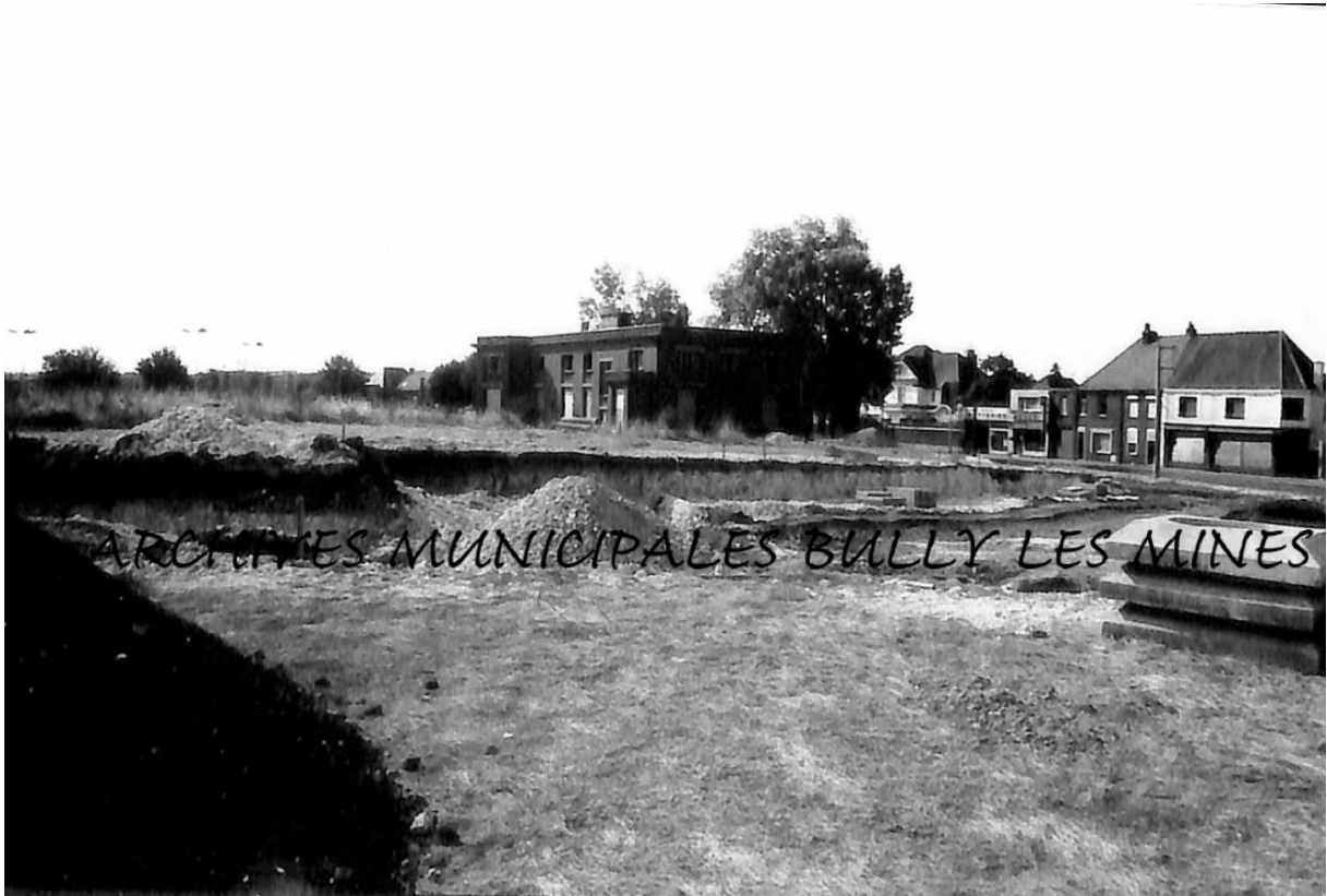
Nous vous présentons une photo, de 1990, présentant les travaux de construction du rond-point ©source : Archives Municipales Bully les Mines.
