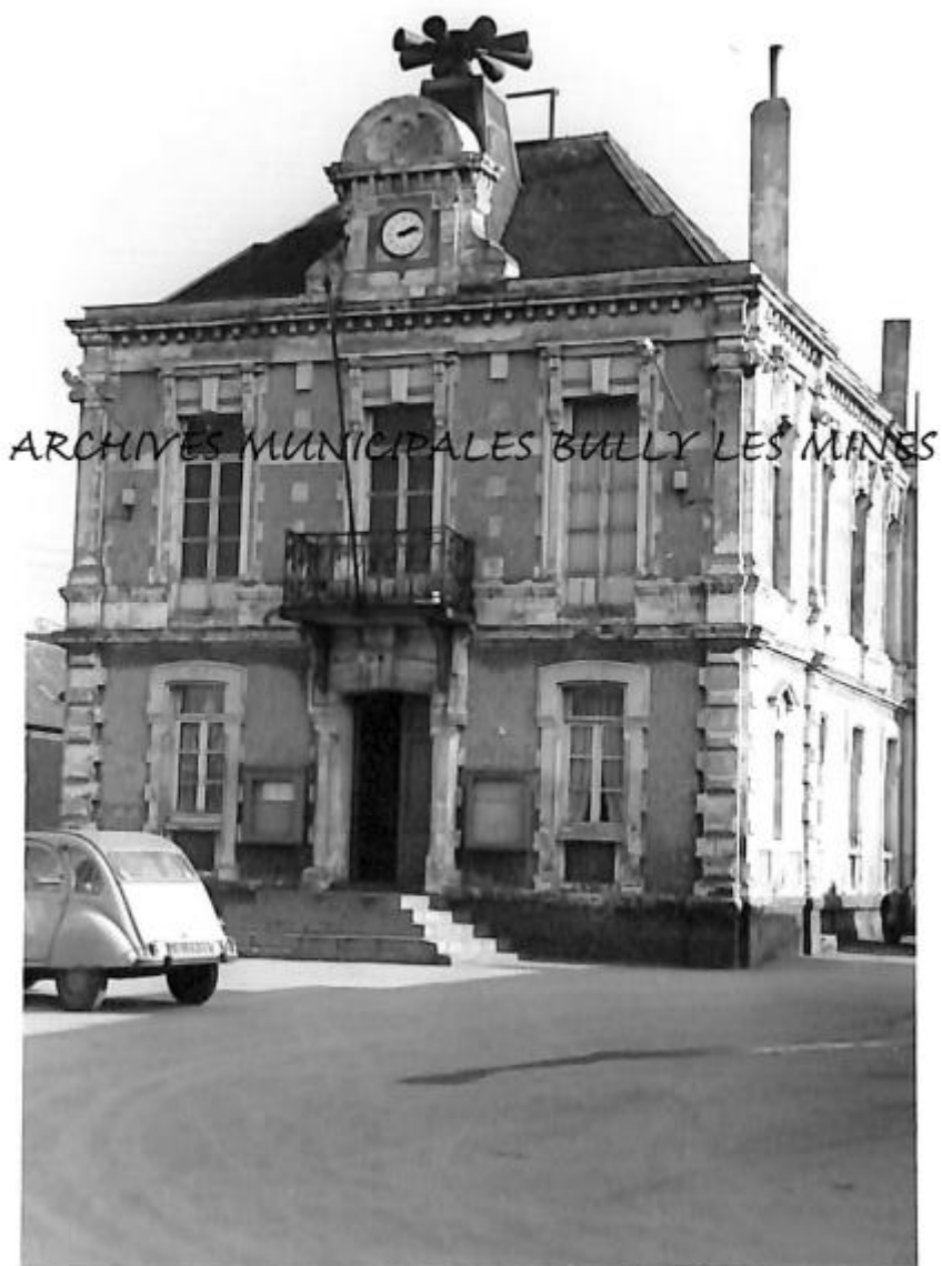
Pour ce mois de février, nous vous présentons une photo des années 1960-1965 représentant l'ancienne mairie (actuellement maison des Associations Jean MALLET). Au premier plan, une 2 cv en stationnement. ©source : Archives Municipales Bully les Mines.
